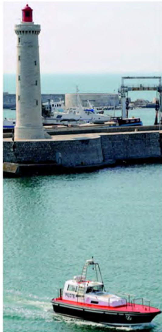
Port de Sète - crédit photo Laurent Boutonnet
